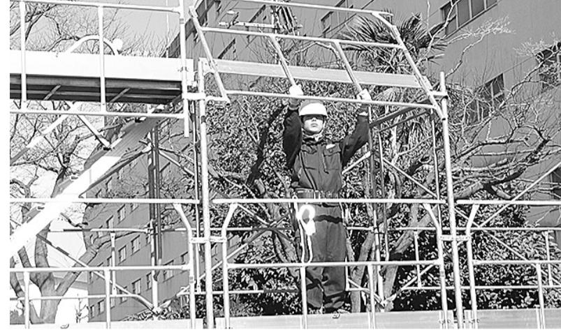
第564条 足場の組立て、解体又は変更の作業に安全帯取付設備の設置を義務化。なお、この場合、手すりの設置を優先的に講ずるよう指導すること
