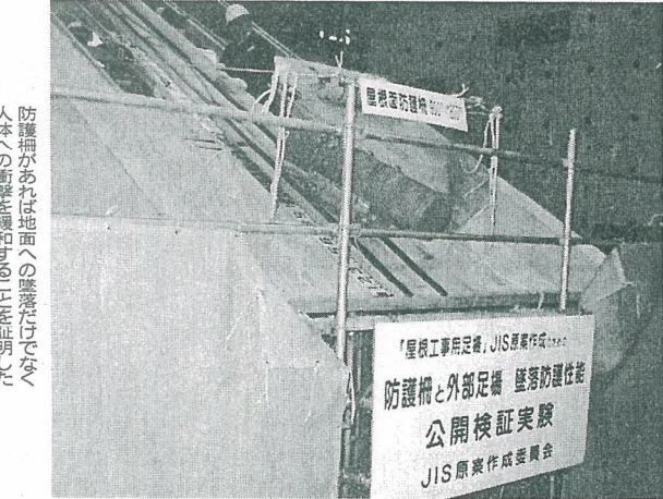
屋根工事用足場 JIS原案作成で公開実験
