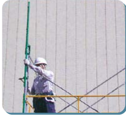
1 建枠上端に先づけ手摺支柱の差し込み、取り付け
