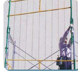
4 手すりユニットの持ち上げ
