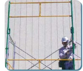
5 建枠上端に差し込み取り付け
