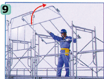
9 上下逆に仮置きしたライフガードの上方を持ち、手前に引きながらライフガードを180°反転させます。*
