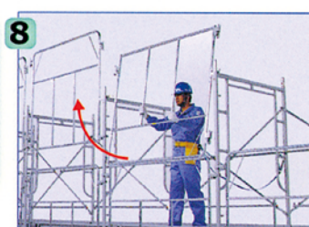
8 2層目の建わく横架材にライフガードを仮置きします。
