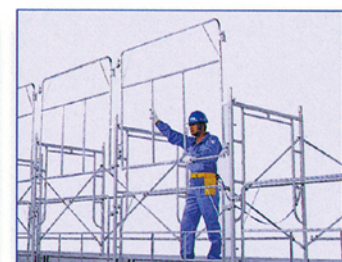
9 上下逆に仮置きしたライフガードの上方を持ち、手前に引きながらライフガードを180°反転させます。*
