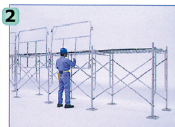
2 足場外側にライフガードを取付けます。
