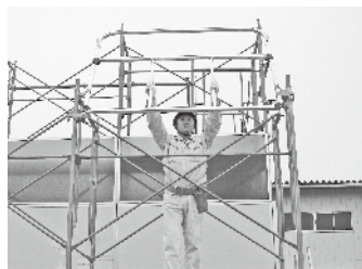
2. 先行手すり枠の下部固定金具が枠組の脚柱にセットできる位置まで半転させます。
