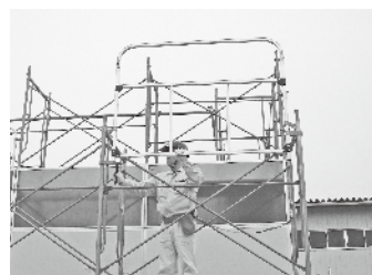
4. 先行手すり枠の下部固定金具にクサビを打ち込んで固定します。もう一方の下部固定金具を同様にクサビを打ち込んでセット完了。
