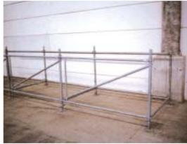
・配置したジャッキベースにボトムバーチカル・ボトムフレームの順に組み立てていく。
