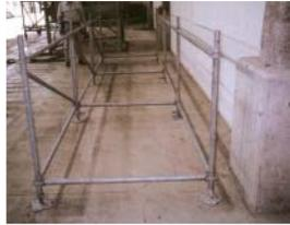
通り墨よりジャッキベースの芯位置及び通りを確認し、ジャッキベースの天端のレベルを再確認する。
