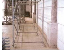
・内側長手方向に水平材を、直角方向にユニットフレーム用水平材を取付ける。
