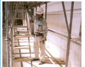
・二段目に布板(シルクロード・鋼製踏板)を取付ける。この時、ロックがしてあるか確認すること。
