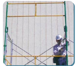
5 建枠上端に差し込み取り付け
