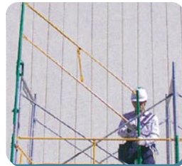
3 もう一方に先づけ手摺支柱に二段手摺の取り付け
