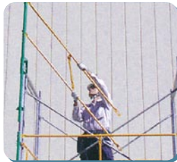
2 先づけ手摺柱に、二段手摺の差し込み、取り付け
